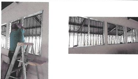
foto 5 cambio de ventanas
