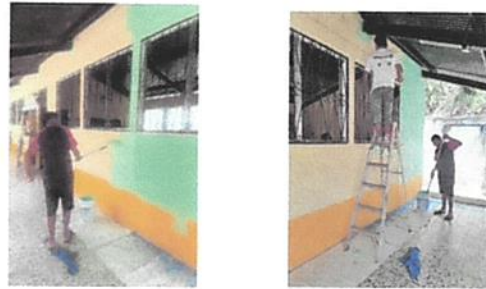
foto 4 pintura en muros
