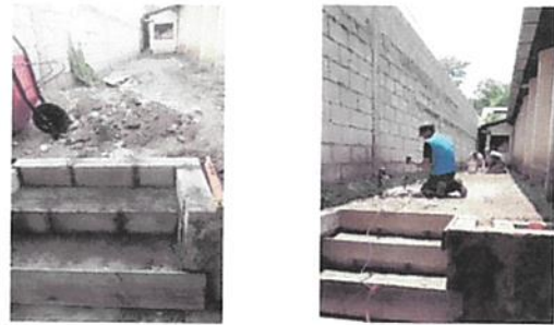
foto 2 reconstruccion de torta de concreto
